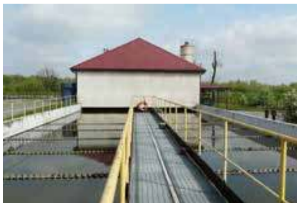
Oczyszczalnia ścieków Lubartów, osadniki wtórne
